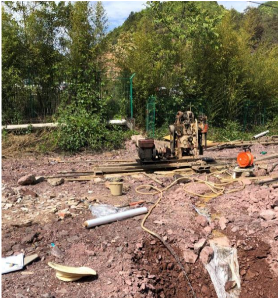
HS3 现场抽水照片
