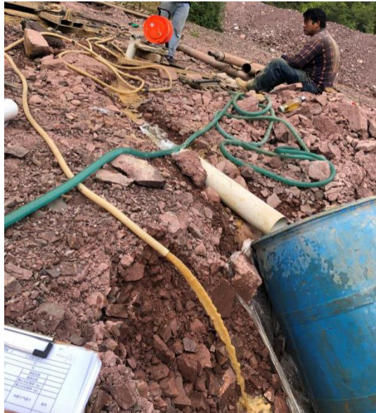
HS3 现场抽水照片
