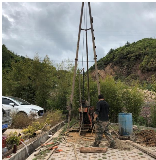
HS5 现场钻探照片
