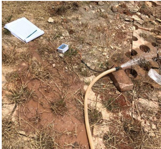
HS5 现场抽水照片
