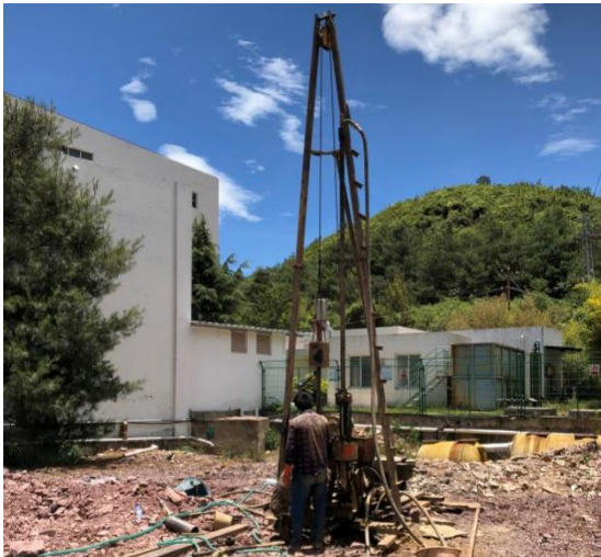
HS3 现场钻探照片
