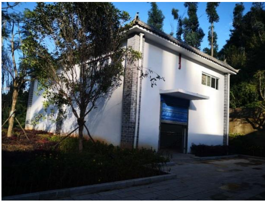
吊草村已建自来水加压泵房
