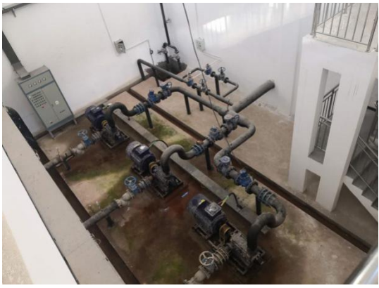
吊草村已建自来水加压泵
