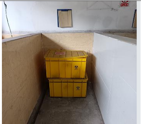
危废暂存间内部
