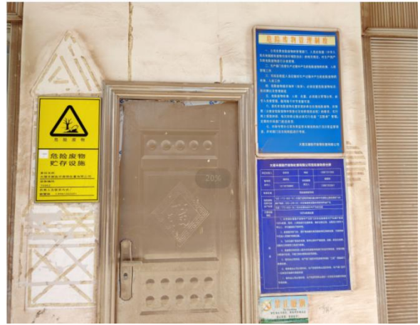
危废暂存间外部
