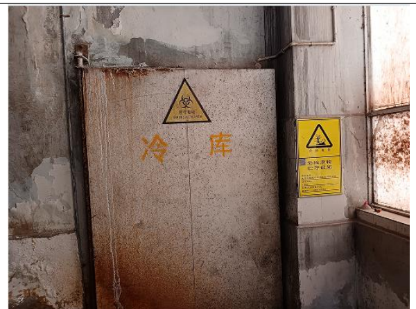
医疗废物暂存间（冷库）
